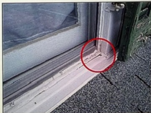
21. Moisture damage
