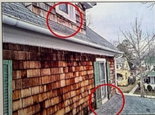
20. Moisture damage
